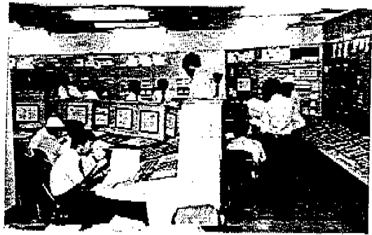
写真 7-3 中央制御盤及び中央監視盤の実寸大モデルによる検討作業状況 中央制御盤(奥側)と中央監視盤(手前側)
