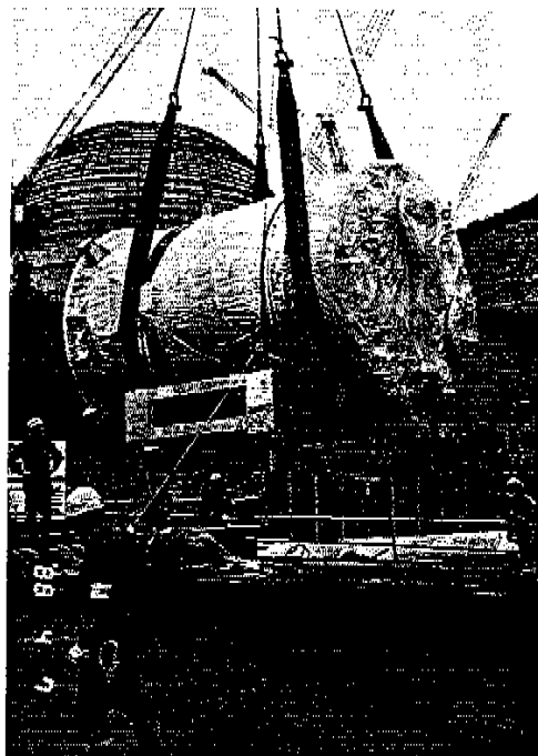
写真4 廃液タンクの搬入
