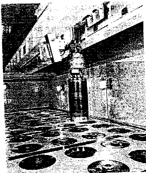
写真3 保管ビット上部 (ガラス固化体の保管能力は420本)
