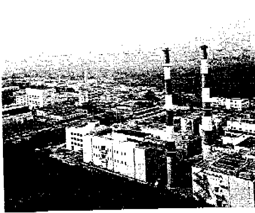
写真1 ガラス固化技術開発施設の全景
