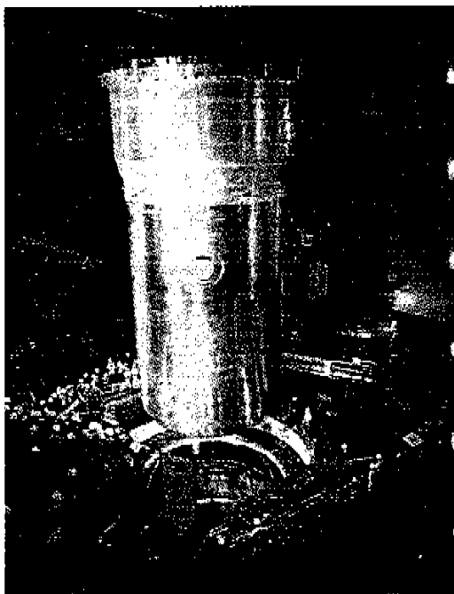
写真3 原子炉容器 据付状況 88年10月24日
