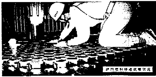
写真3 燃料交換装置作動確認
