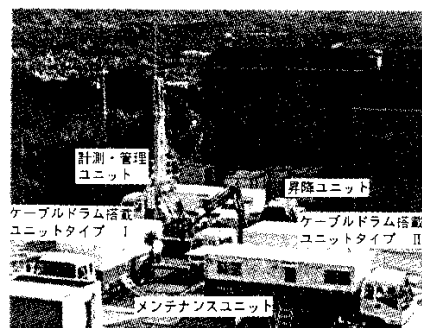
写真2 第3回試験の現場状況
