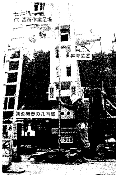
写真3 第2回試験での昇降装置の周囲状況
