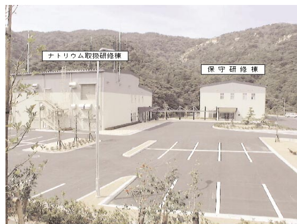
写真1 FBRサイクル総合研修施設の外観
