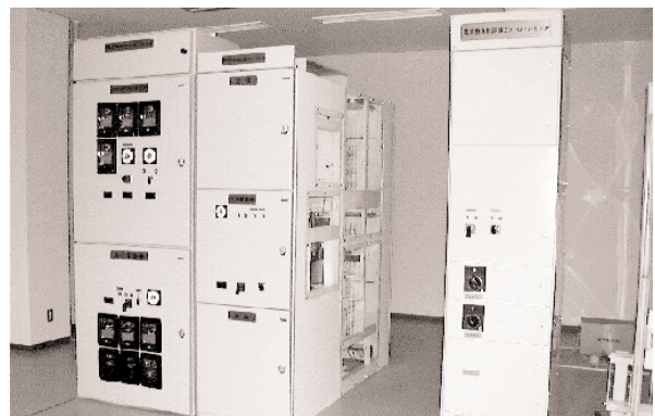
写真 9 電源盤点検設備の外観
