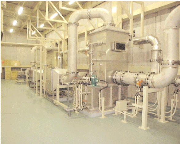
写真4 給気 / 排煙処理装置の外観
