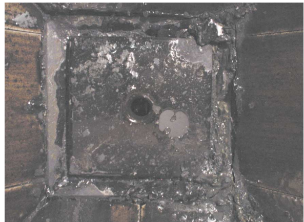
写真3 ドレンアウト後の底部状況
