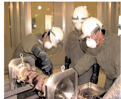
漏えい後の配管解体研修状況
