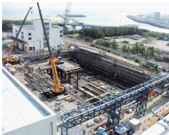
写真1 LWTFの工事外観
