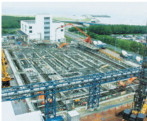
写真1 LWTFの工事外観
