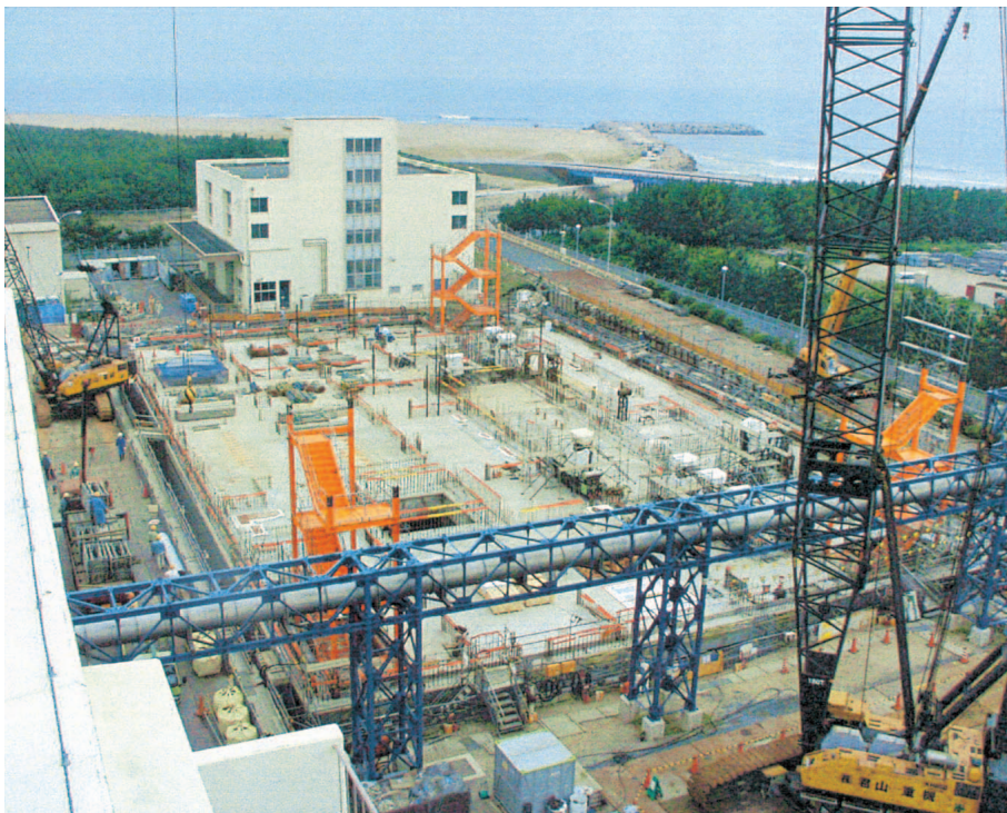
写真1 LWTFの工事外観
