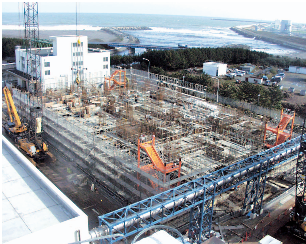
写真1 LWTFの工事外観
