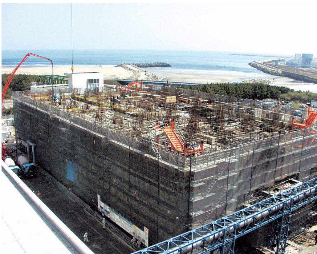
写真1 LWTFの工事外観（2004年3月撮影）
