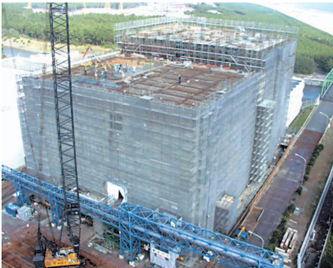
写真2 LWTFの工事外観
