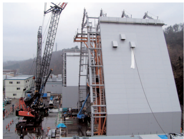
写真1 瑞浪超深地層研究所：研究坑道掘削状況
