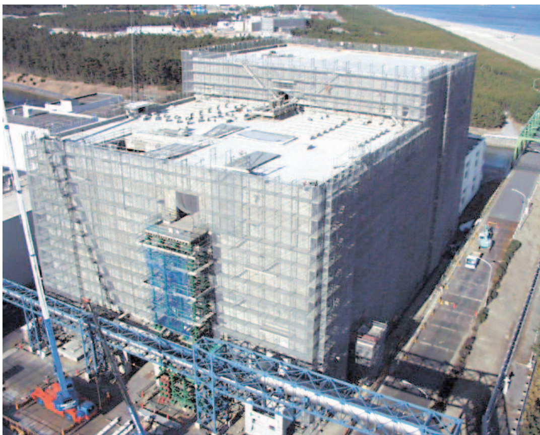
写真1 LWTFの工事外観
