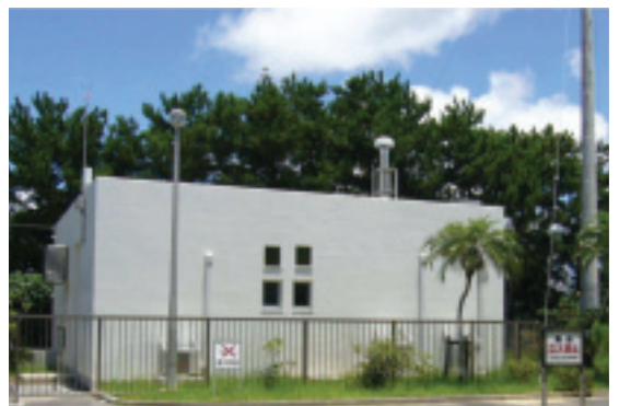
図11-2 CTBT沖縄放射性核種監視観測所の外観 大気中微粒子捕集・放射性核種観測装置の整備を行い、沖縄観測所は2007年2月にCTBT機関の公認施設として認定され運用を開始しました。
