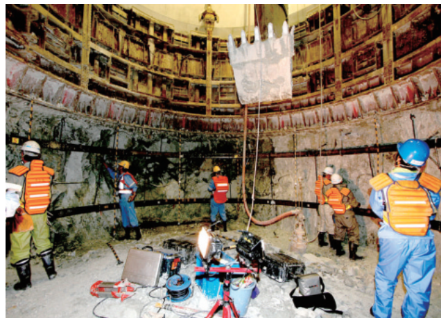
立坑坑底における地質調査
