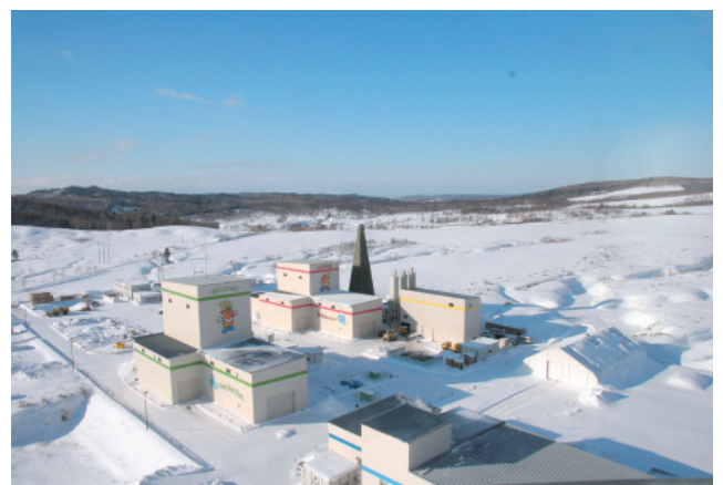
PR施設の展望室から望む冬季の地下施設現場
