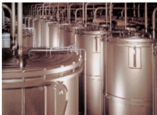
(a) ウラン濃縮プラント カスケード
