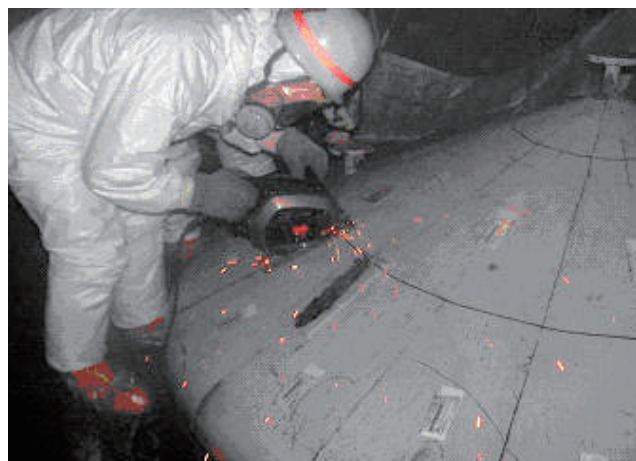
転換施設解体写真
