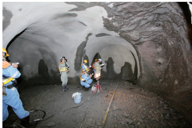
深度300m研究アクセス坑道における地質調査
