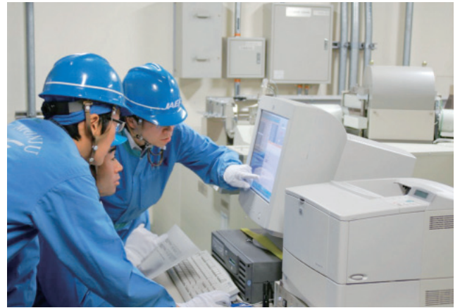
プラント確認試験における破損燃料検出装置の試験データの確認
