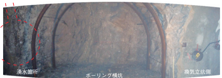
図14-26 深度200mボーリング横坑（換気立坑）を掘削した時の坑道壁面 プレグラウチング注入孔を掘削した時に発生した湧水箇所付近の坑道壁面からは、にじみ出し程度の湧水はあるものの顕著な湧水は認められませんでした。
