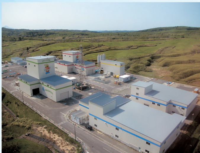
幌延深地層研究センターの地下施設
