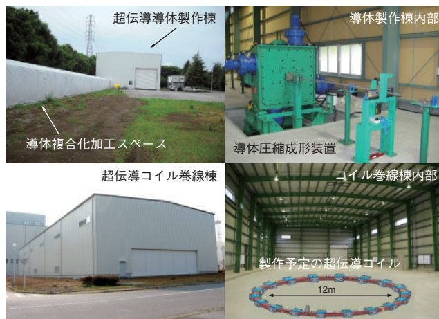
超伝導体製作棟及び超伝導コイル巻線棟とその内部
