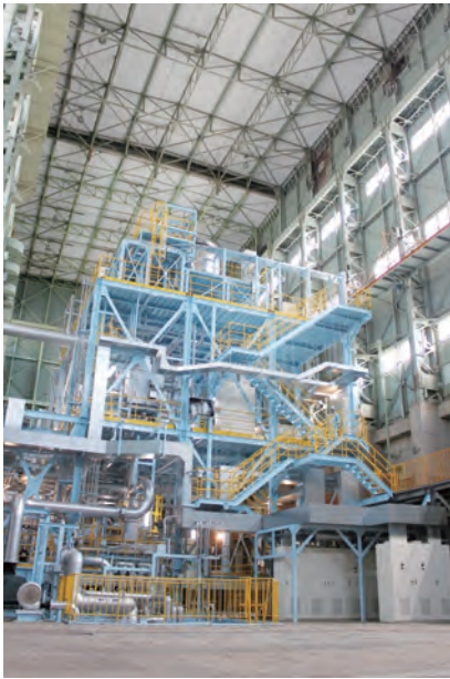
図12-16 試験ループ全景 高さが4階建てビルに相当する液体リチウム試験ループ (Li保有量2.5 t) です。
