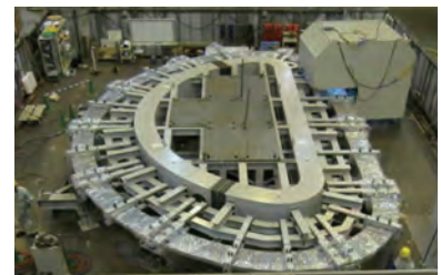
図3-4 実規模(13m×8m)ラジアル・プレートの試作 10枚のプレートを溶接中の試作品です。
