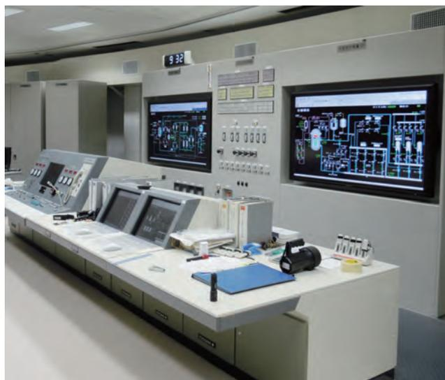
計測制御系統の据付を完了したJMTR制御室
