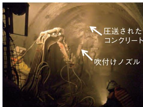
図 2-23 坑道壁面への吹付け状況
