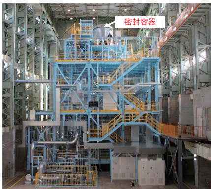
図 3-27 完成したIFMIF/EVEDA液体Li試験ループ Li保有量は2.5 t (5000 ℓ)、高さ20 m×幅15 m×奥行き15 mの3フロア構造であり、最上部の密封容器内に試験部であるターゲットアセンブリがあります。
