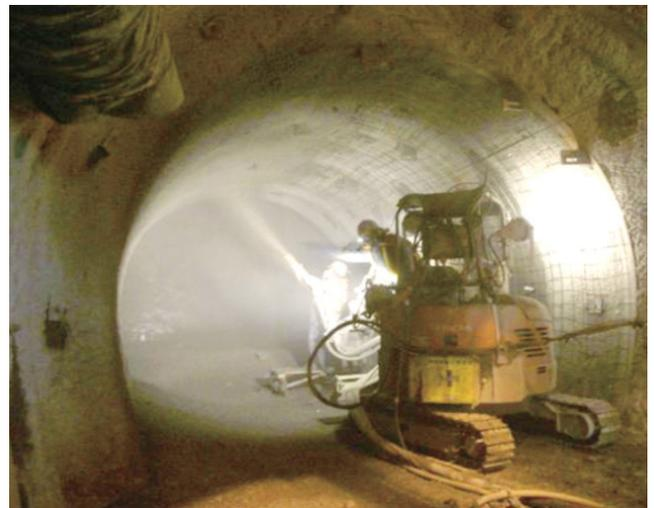
深度250 mの調査坑道における低アルカリ性セメントの施工試験
