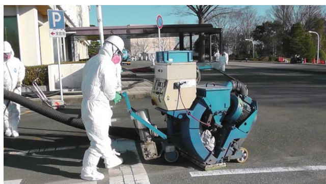
図 1-15 ショットブラスト工法による除染作業(大熊町役場周辺) 直径 1 mm 程度の鉄球を高速で除染対象に衝突させ、除染対象の表面を薄く切削する除染方法です。原子力施設内で使用されている方法を道路に適用し、大熊町役場周辺での実績では、表面汚染密度を90%以上低減させることができました。
