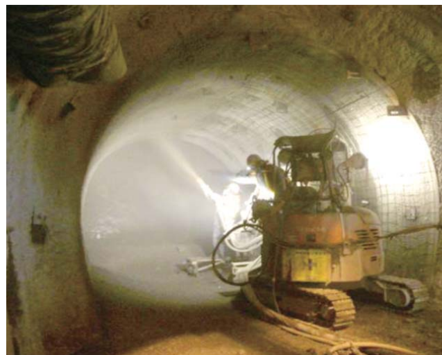
深度250 mの調査坑道における低アルカリ性セメントの施工試験
