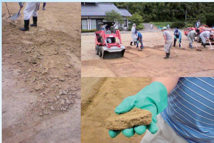
福島県伊達市霊山町小国で行ったポリイオン複合体を利用した土壌除染の様子
