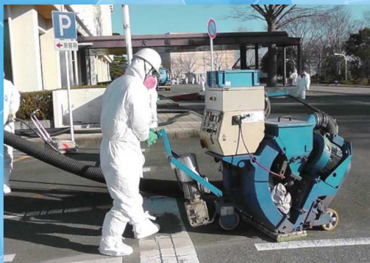
ショットブラスト工法による路面の除染作業
