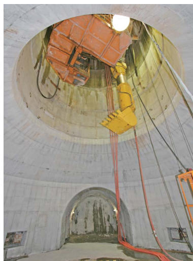
深度500 mにおける主立坑と水平坑道との接続部分
