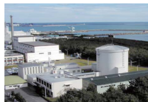
原子炉安全性研究炉（NSRR）
