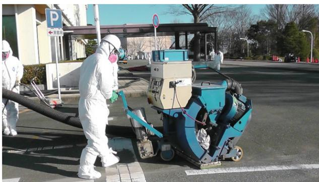
図 1-15 ショットブラスト工法による除染作業(大熊町役場周辺)
