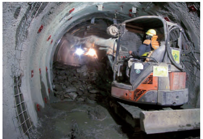
深度350m調査坑道における換気立坑と東立坑間の貫通
