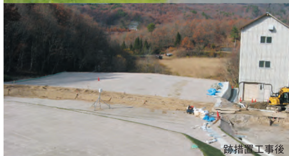
跡措置工事前後の廃砂たい積場
