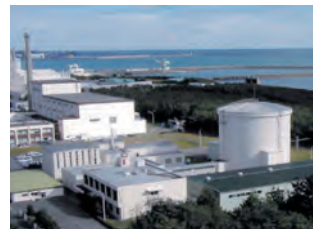
原子炉安全性研究炉（NSRR）
