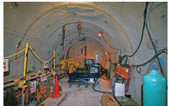
図13-23 深度500 m におけるボーリング調査 深度500 m における坑道掘削領域を対象としたボーリング調査の様子です。
