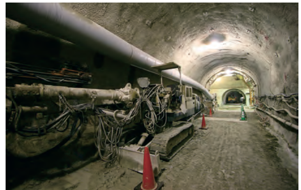
図13-22 深度500 m 研究アクセス北坑道 深度500 m 研究アクセス北坑道（幅5 m, 高さ4.5 m）から主立坑方向を見た様子です。
