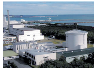
原子炉安全性研究炉（NSRR）
