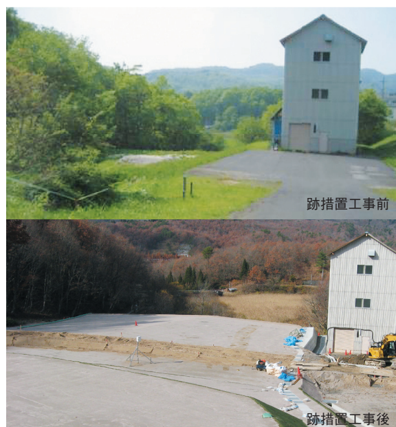
跡措置工事前後の廃砂たい積場
