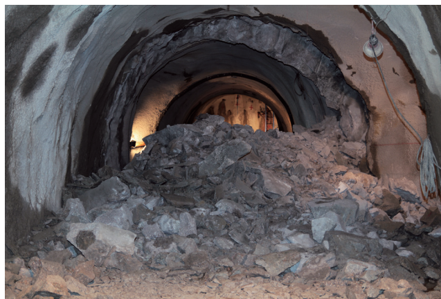
深度 500 m 水平坑道（予備ステージ）における坑道貫通部分（2012 年 7 月 30 日貫通）
