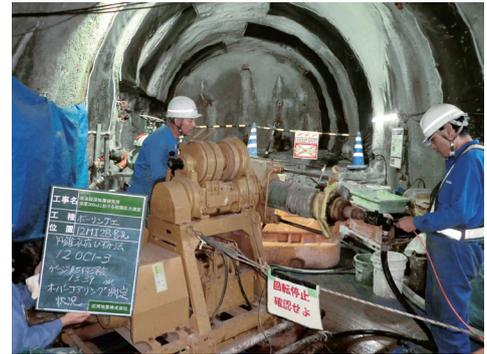
図3-8 岩盤応力測定の状態
