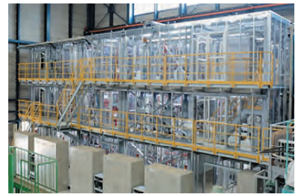
横18.5 m×縦5 m×高さ8.1 m
