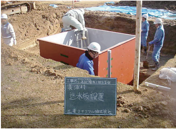
図1-38 美浦村の試験場所の準備状況 6 m 四方の穴を掘削し、2 m 四方の遮水板を設置しました。この遮水板の中に表層を剥ぎ取った除去土壌を図1-39のように埋設して、試験を実施しました。
