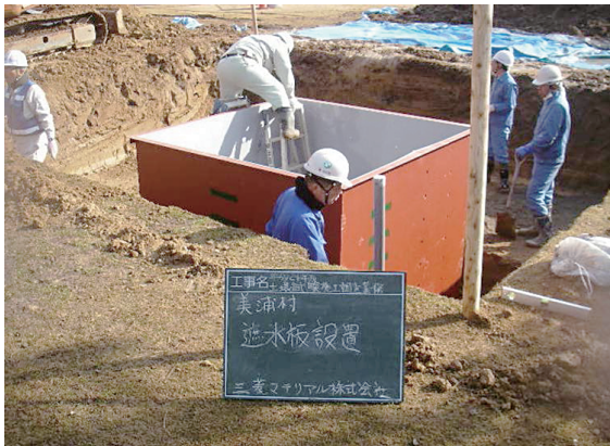
図1-38 美浦村の試験場所の準備状況 6 m 四方の穴を掘削し、2 m 四方の遮水板を設置しました。この遮水板の中に表層を剥ぎ取った除去土壌を図1-39のように埋設して、試験を実施しました。
