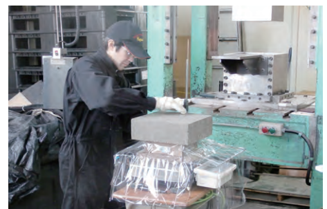
図 8-15 埋め戻し材ブロックの製作 本試験では、人力による設置としたため、30 cm × 30 cm × 10 cm、重量約 16 kg のブロックとしました。奥に見える 80 t プレス機にて圧縮成型して製作しました。
