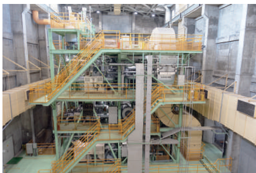
図7-2 プラント過渡熱流動ナトリウム試験装置
